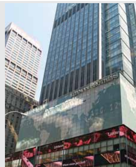
مبنى بنك ليمان براذرز
